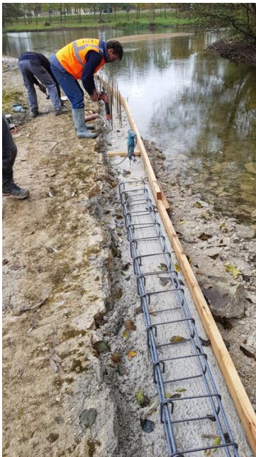
Figure 24 - Mise à niveau du seuil (Exemple 1).
