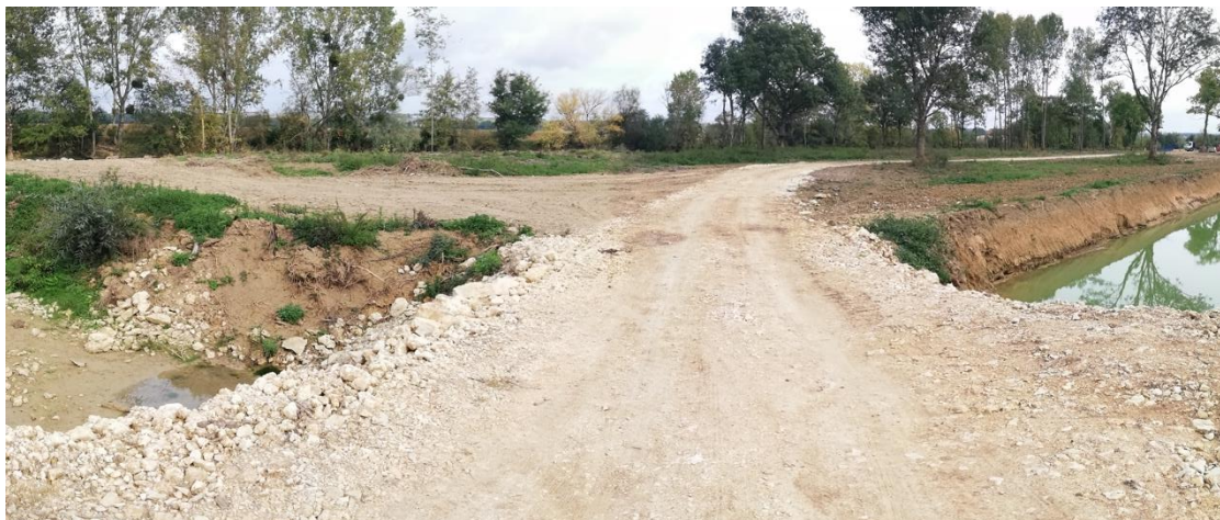
Figure 22 - Exemple de batardeau réalisé pour franchir un cours d'eau.
