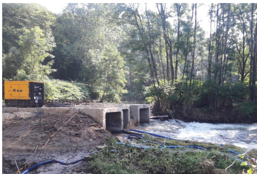
Figure 23 - Exemple de pose de batardeau en dalots.
