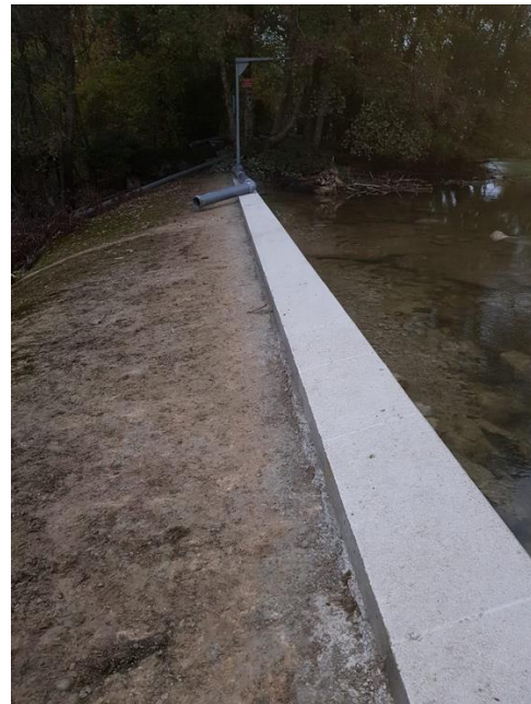
Figure 25 - Mise à niveau du seuil (Exemple 2).
